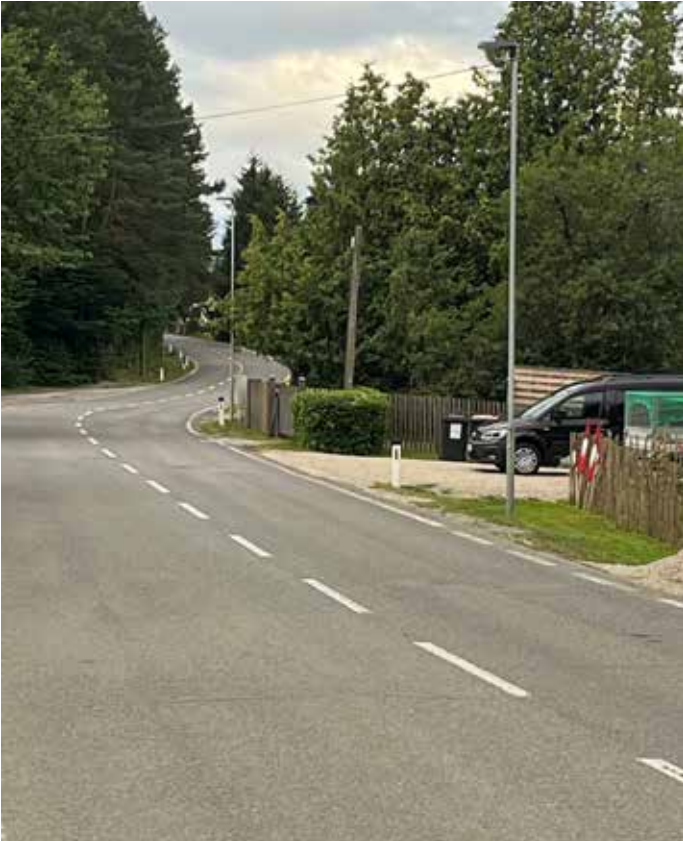
Am rechten Fahrbahnrand wird die Ortswasserleitung verlängert und darüber der Gehsteig errichtet
